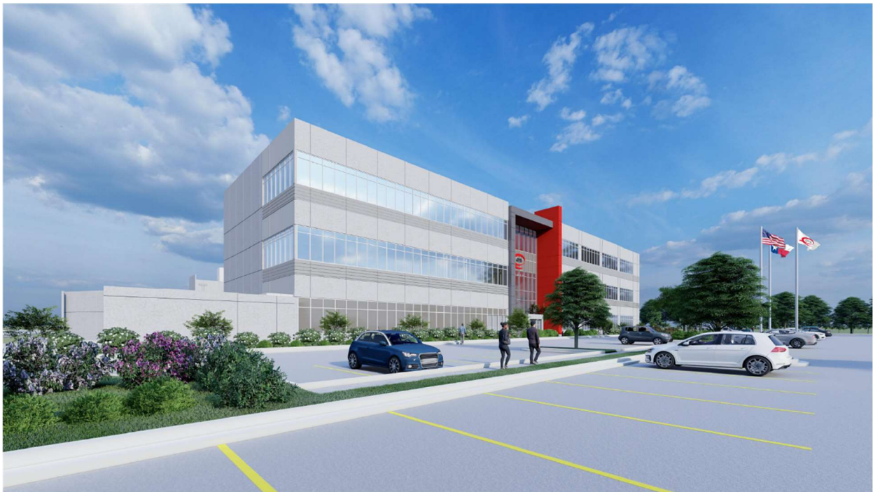
CBRE, QTS Data Center
